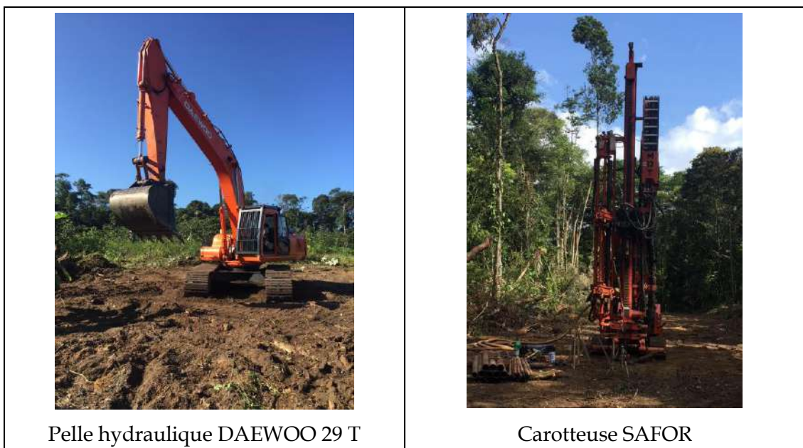
Planche photo 2. Détail du matériel de forage.
