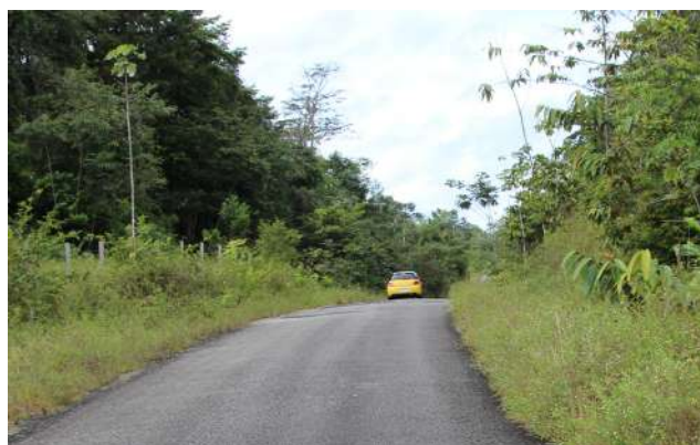
La route qui longe le site en sa partie est se trouve, globalement, en bon état. On constate sur cette vue la manière dont ce ruban de bitume épouse les moindres sursauts du relief.
